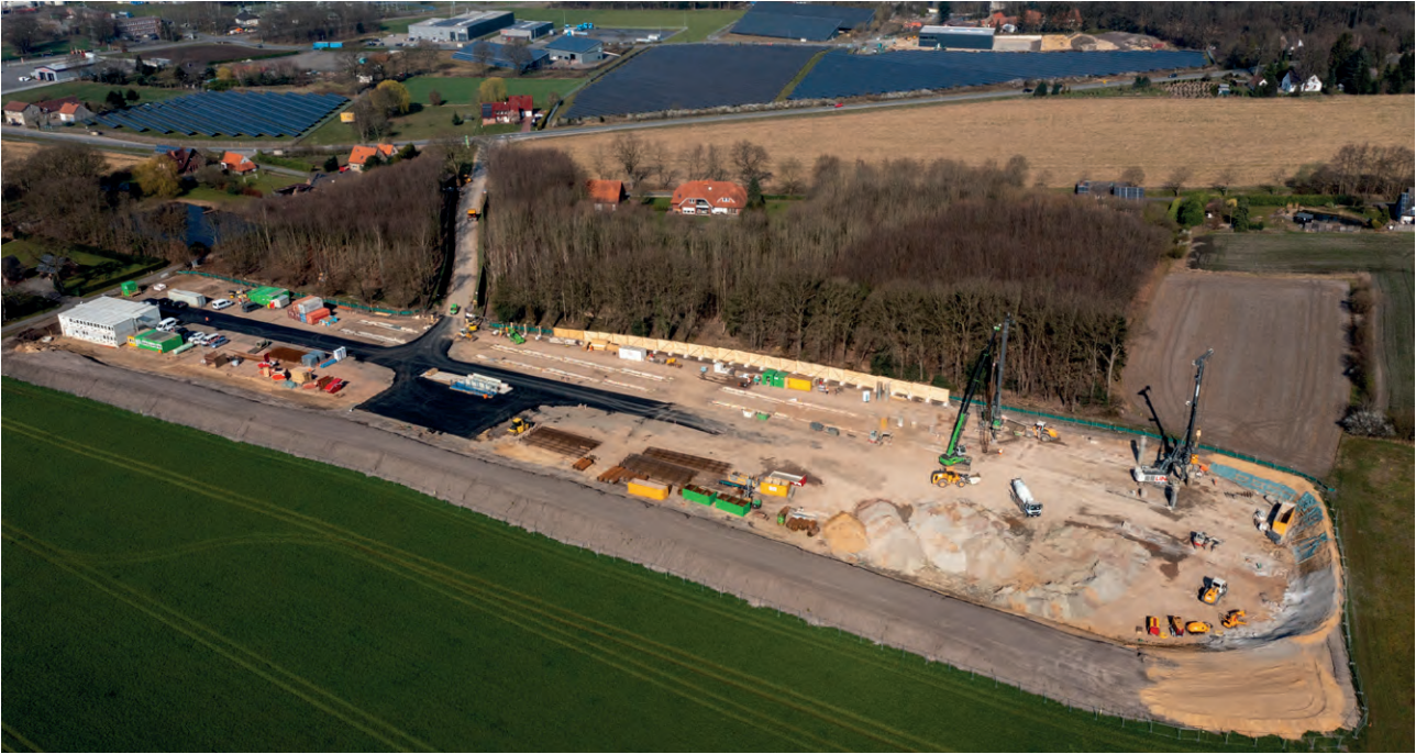
Bild 6.9 – Bauphase am Auslaufbauwerk (Quelle RAG AG)
