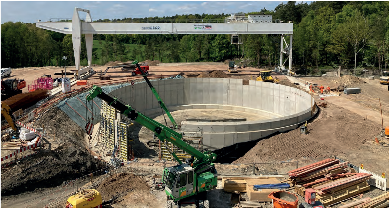
Bild 6.10 – Bauphase am Mittelschacht (Quelle: RAG AG)
