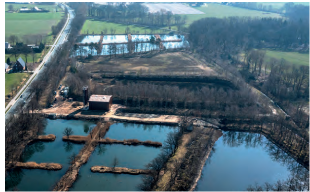
Bild 5.2 – Grubenwasserbehandlungsanlage Püßelbüren im Bau (Quelle: RAG AG)
