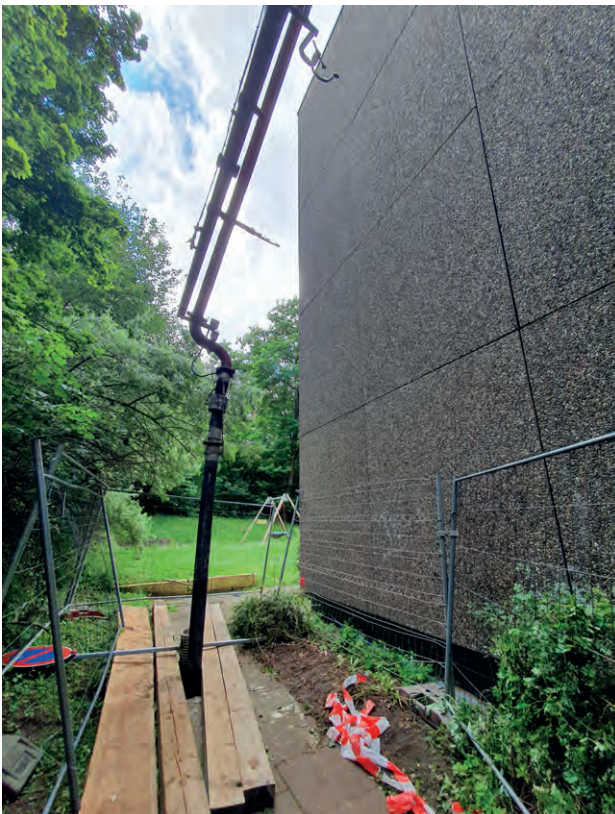
Bilder 10.5 und 10.6 – Tagesbruchsicherung unmittelbar neben einem Wohngebäude
