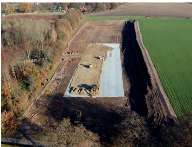
Bild 6.6 – Vorbereitungsphase am Auslaufbauwerk
