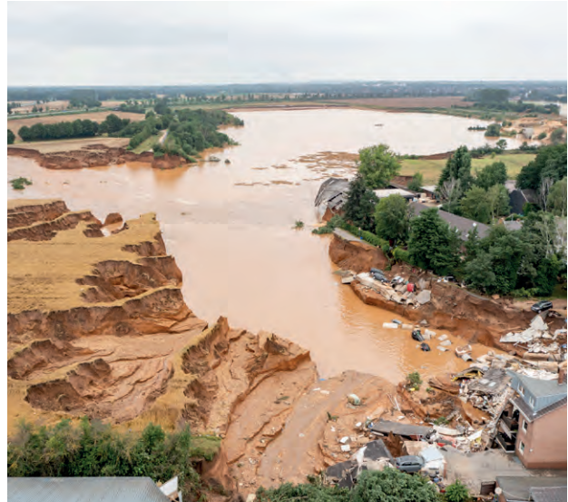
Bild 14.2 – Das Luftbild zeigt den Blick von Erftstadt-Blessem in Richtung Tagebau am 16.07.2021 (Quelle: Bezirksregierung Arnsberg)
