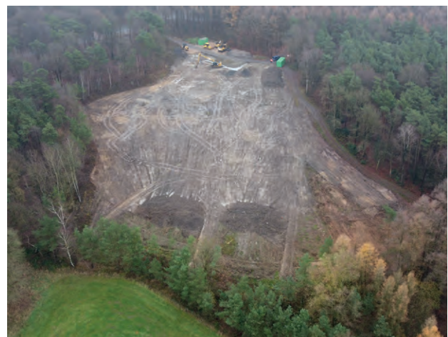
Bild 6.7 – Vorbereitungsphase am Mittelschacht
