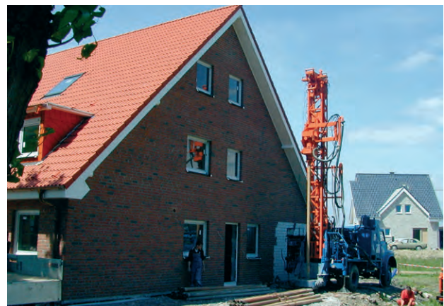
Bild 2.2 – Geothermiebohrung (Quelle: Bezirksregierung Arnsberg)
