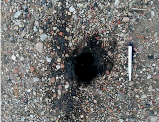
Bild 9.6 – Risse/Löcher in der Haldenoberfläche
