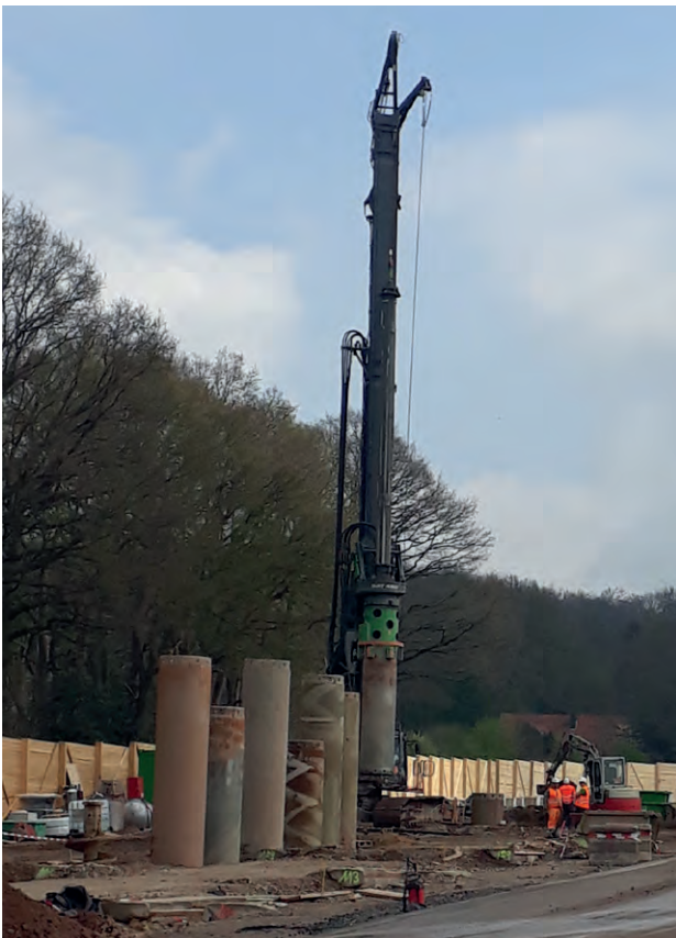
Bild 6.8 – Drehbohrgerät (Quelle: BR Arnsberg)
