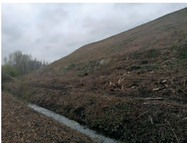
Bild 9.10 – Zu verrohrender Mühlenbach und freigeschnittene Böschung
